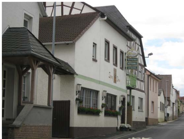
Bild 12: Restaurant in der Hauptstraße
