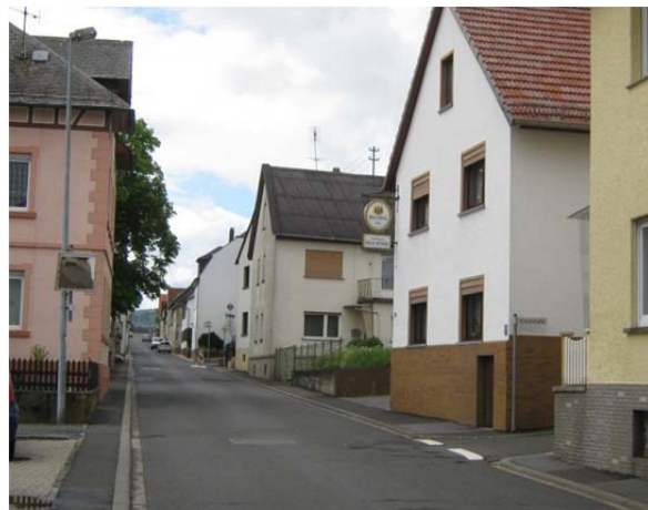
Bilder 64: evtl. Abriss Stromberger Straße 32
