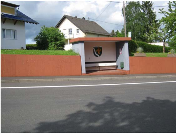
Bild 17: Bushaltestelle in der Stromberger Straße im westlichen Teil
